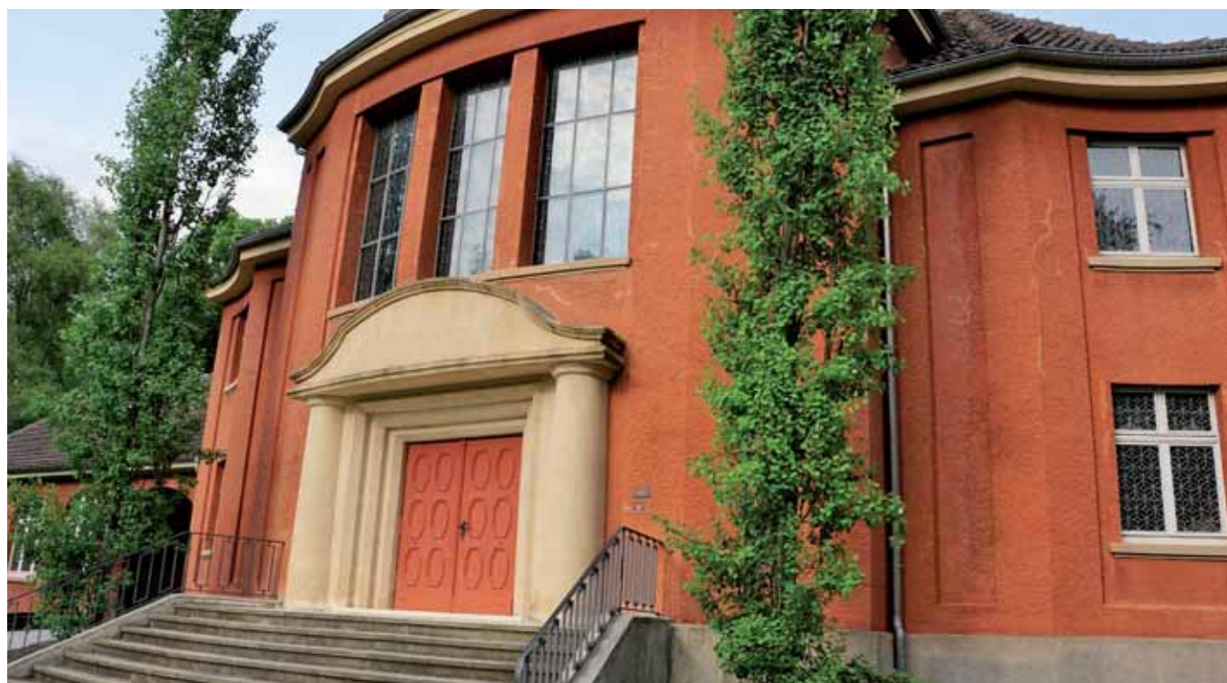
Hier war früher das Krematorium untergebracht. Heute wird das Gebäude für andere große Momente genutzt.
